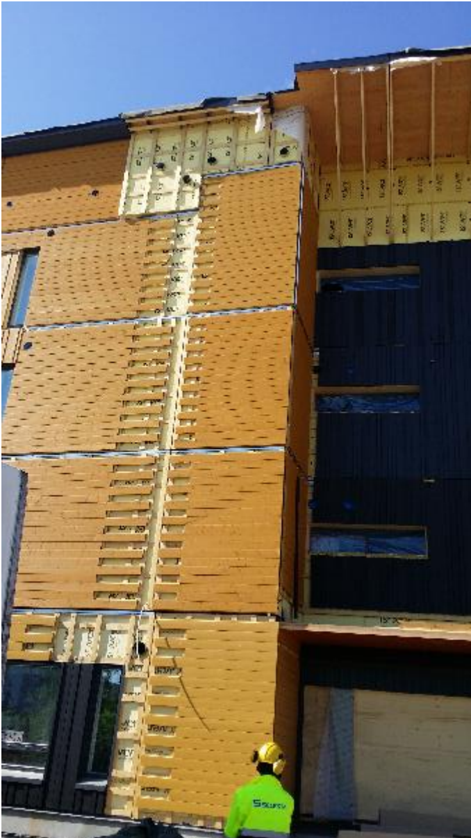
Bilder: Baustelle mehrgeschossige Wohngebäude Honkasuo
